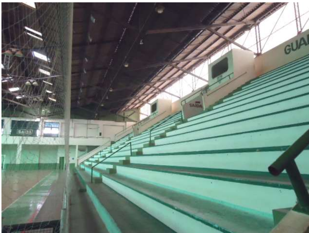
FOTO N.º 224- Aspecto da arquibancada do ginásio.
