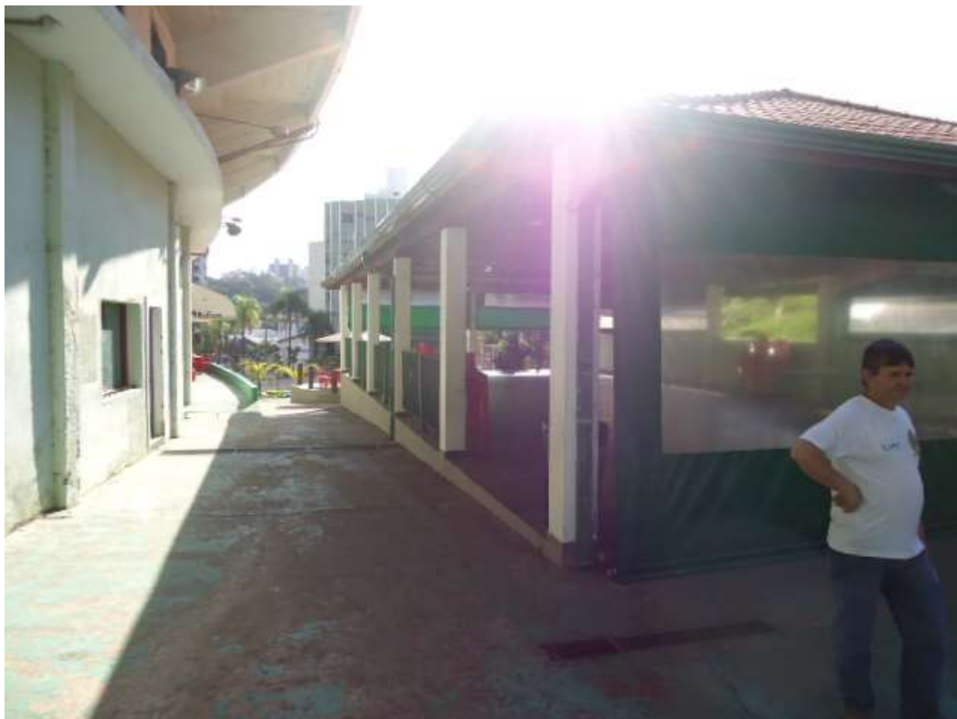
FOTO N.º 235- Tomada do quiosque, denominado rancho verde.
