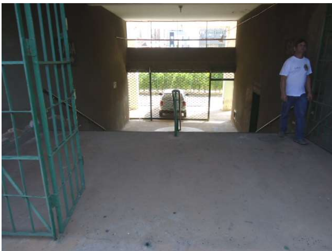
FOTO N.º 111- Aspecto da saída de emergência.
