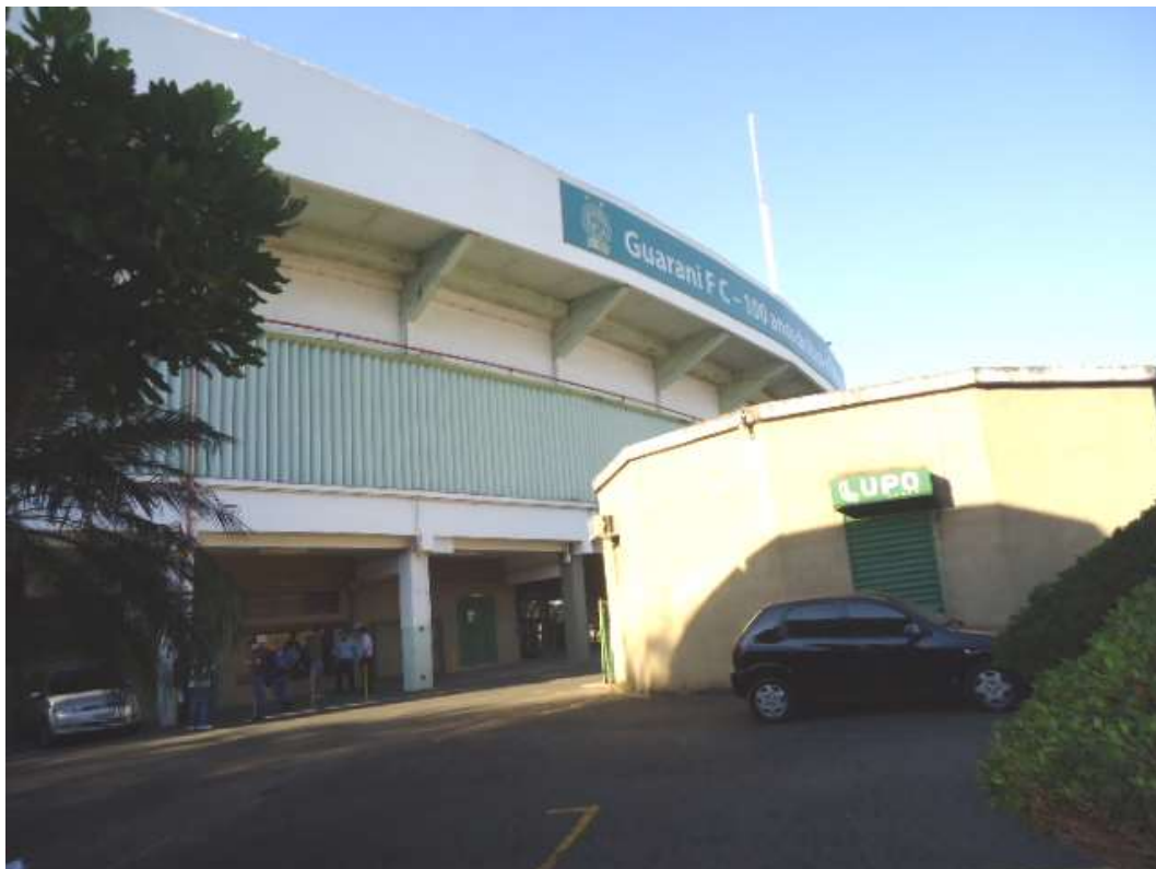
FOTO N.º 318- Aspecto externo do estádio.
