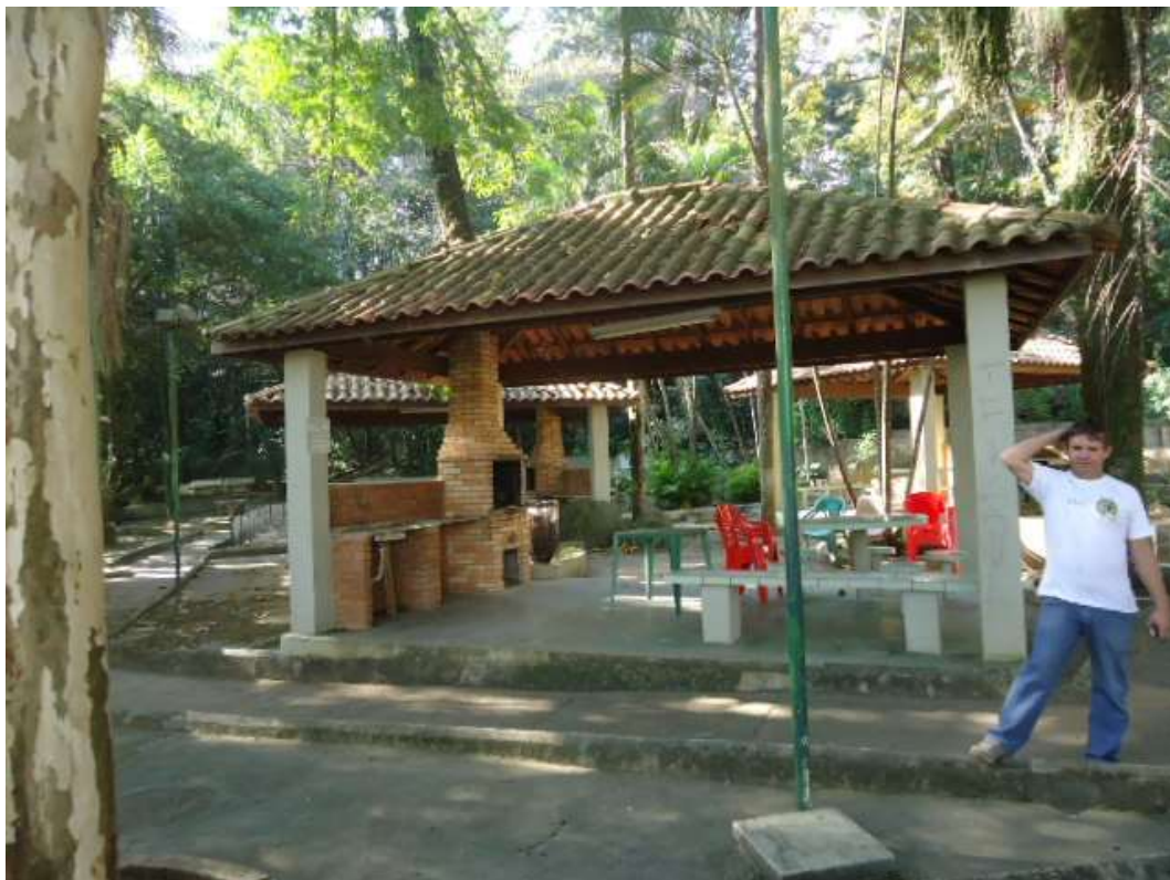
FOTO N.º 207- Aspecto do quiosque n.º 02.
