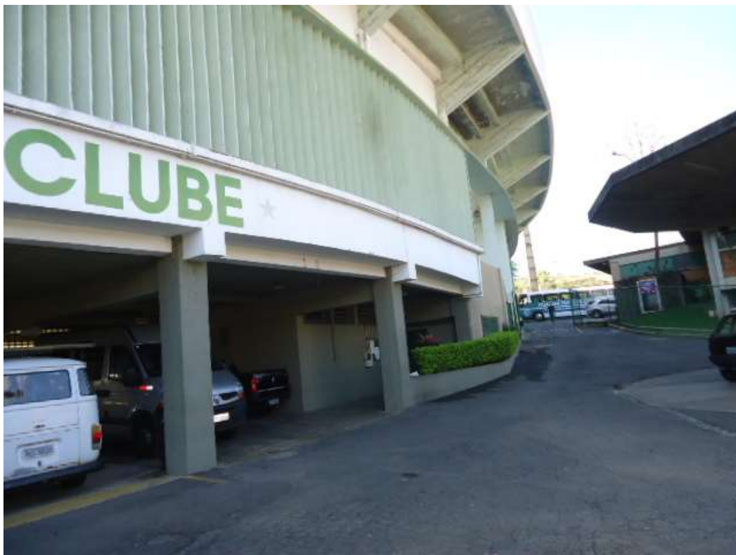
FOTO N.º 46- Aspecto externo do estádio.
