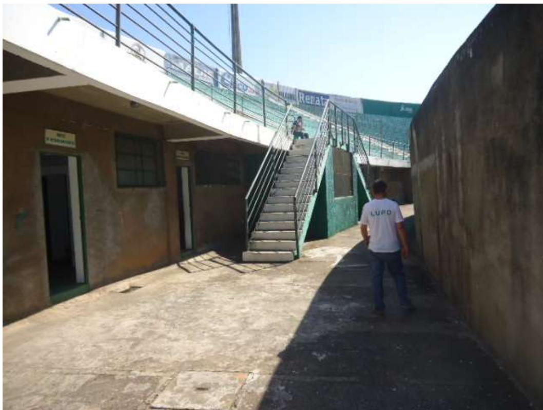
FOTO N.º 79- Tomada externa do banheiro feminino.
