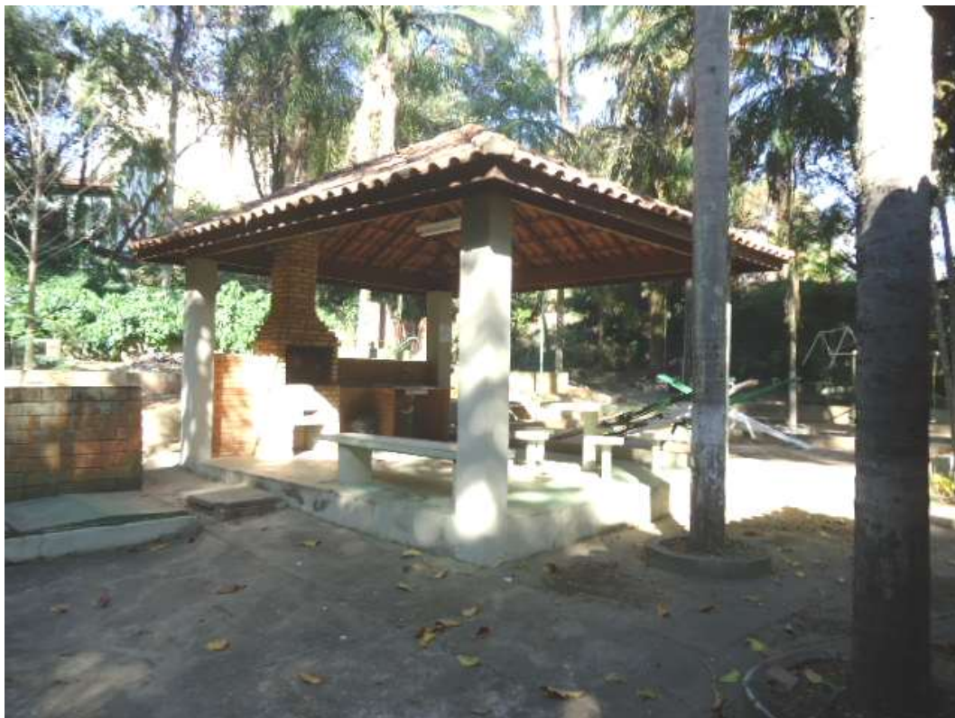
FOTO N.º 209- Aspecto do quiosque n.º 04.
