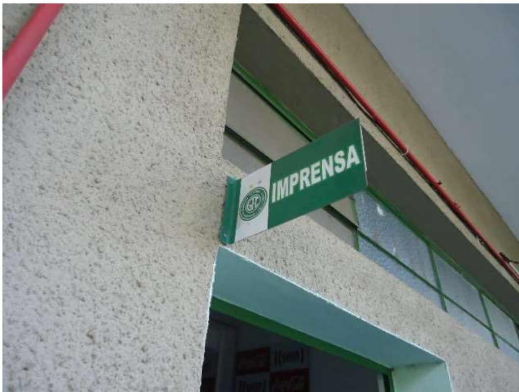
FOTO N.º 54- Detalhe da placa de identificação da sala de imprensa.
