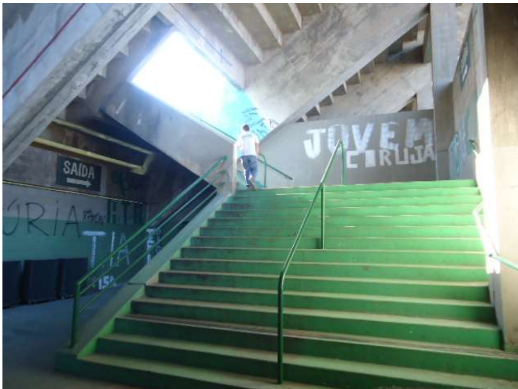
FOTO N.º 275- Vista da escadaria de acesso ao tobogã.
