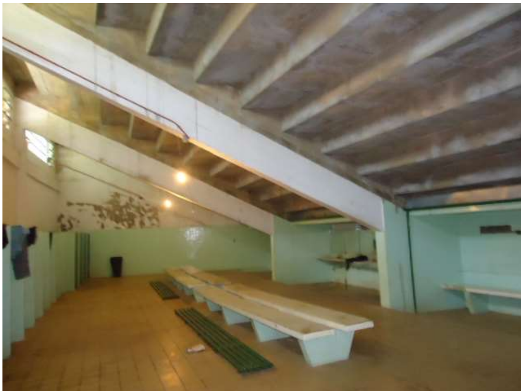
FOTO N.º 242- Tomada interna do vestiário masculino.
