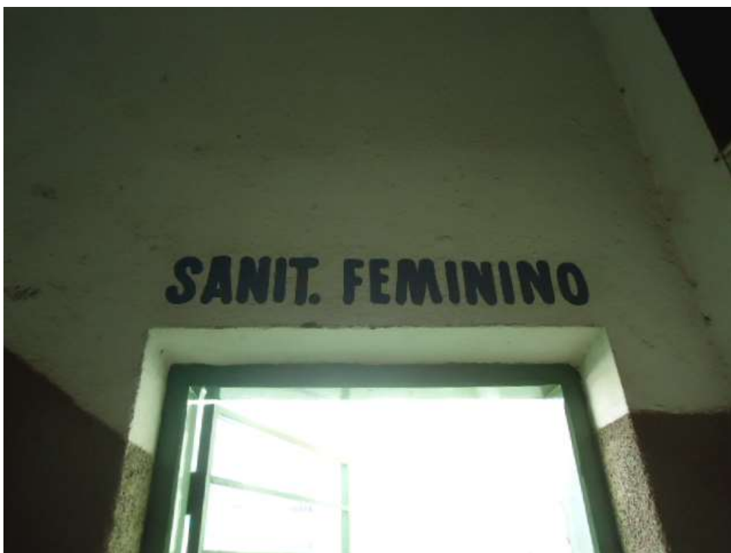
FOTO N.º 133- Detalhe da identificação do sanitário feminino.
