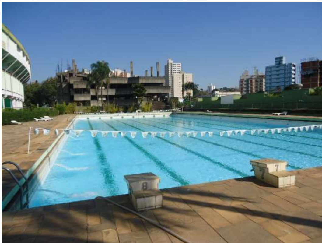
FOTO N.º 178- Vista da piscina olímpica – apresentando com 25,00 m x 50,00 m.
