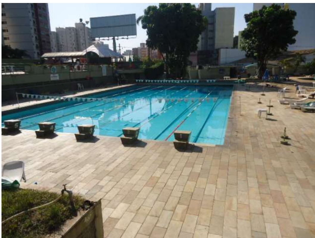
FOTO N.º 179- Aspecto da piscina semi olímpica – apresentando com 14,00 m x 25,00 m.
