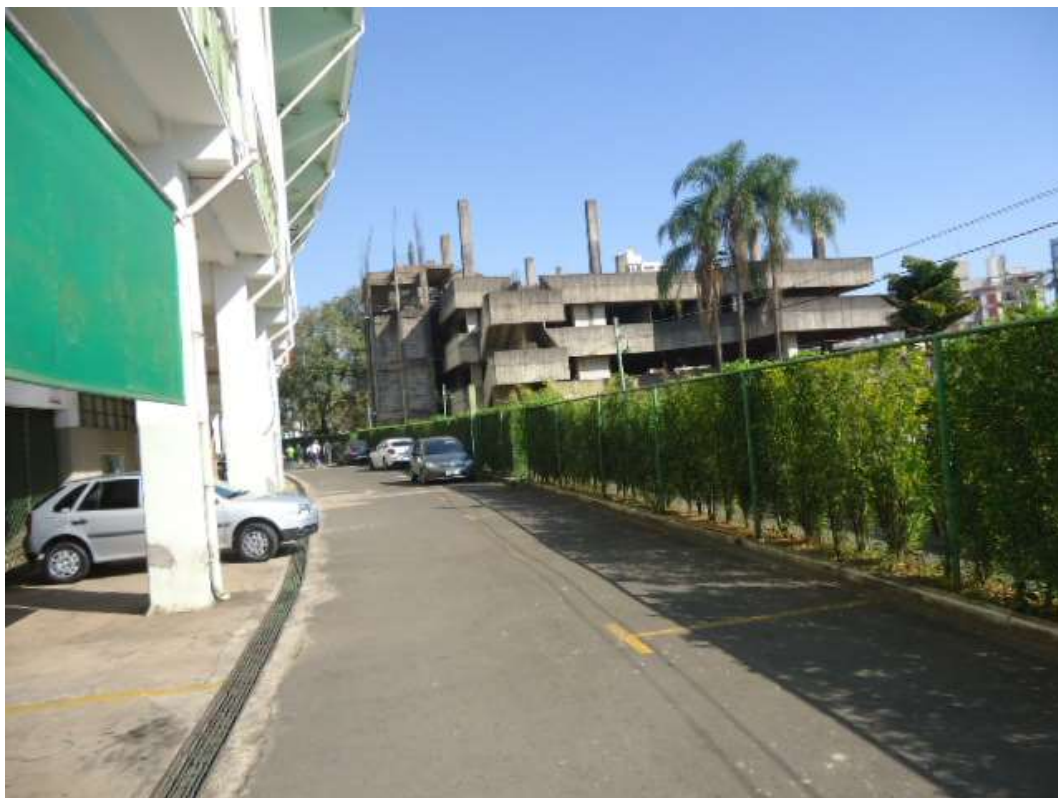
FOTO N.º 153- Vista de rua de circulação interna pavimentada.
