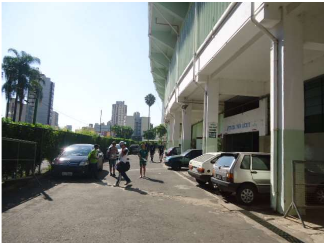
FOTO N.º 94- Aspecto interno do estádio, com rua de circulação interna pavimentada.
