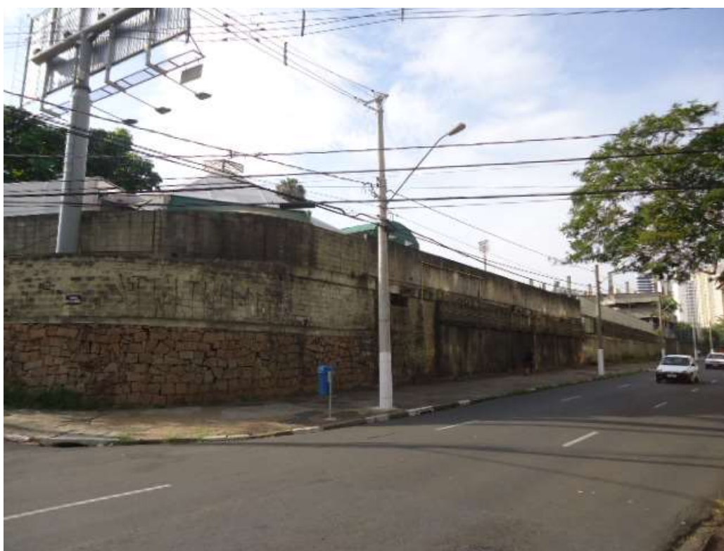
FOTO N.º 17- Vista da fachada para a Av. Princesa D'Oeste.
