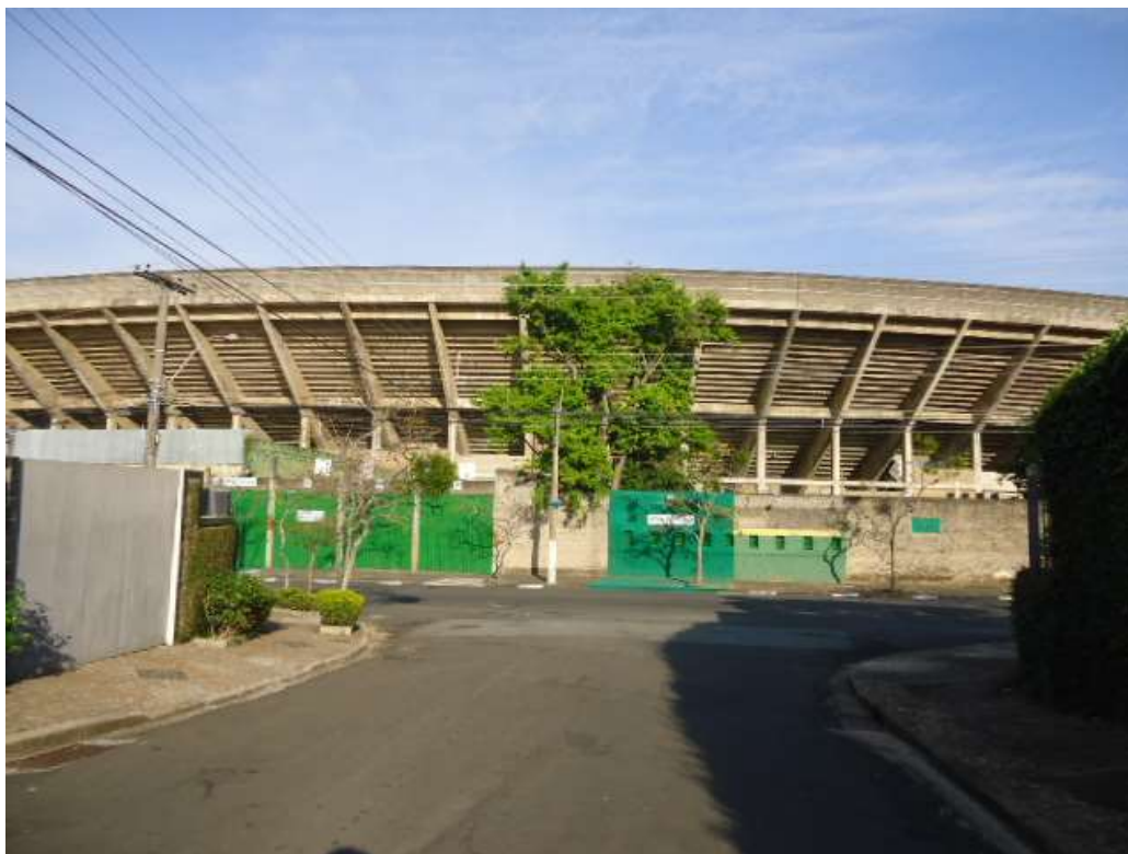
FOTO N.º 32- Tomada externa do estádio, mostrando a arquibancada denominada de tobogã.
