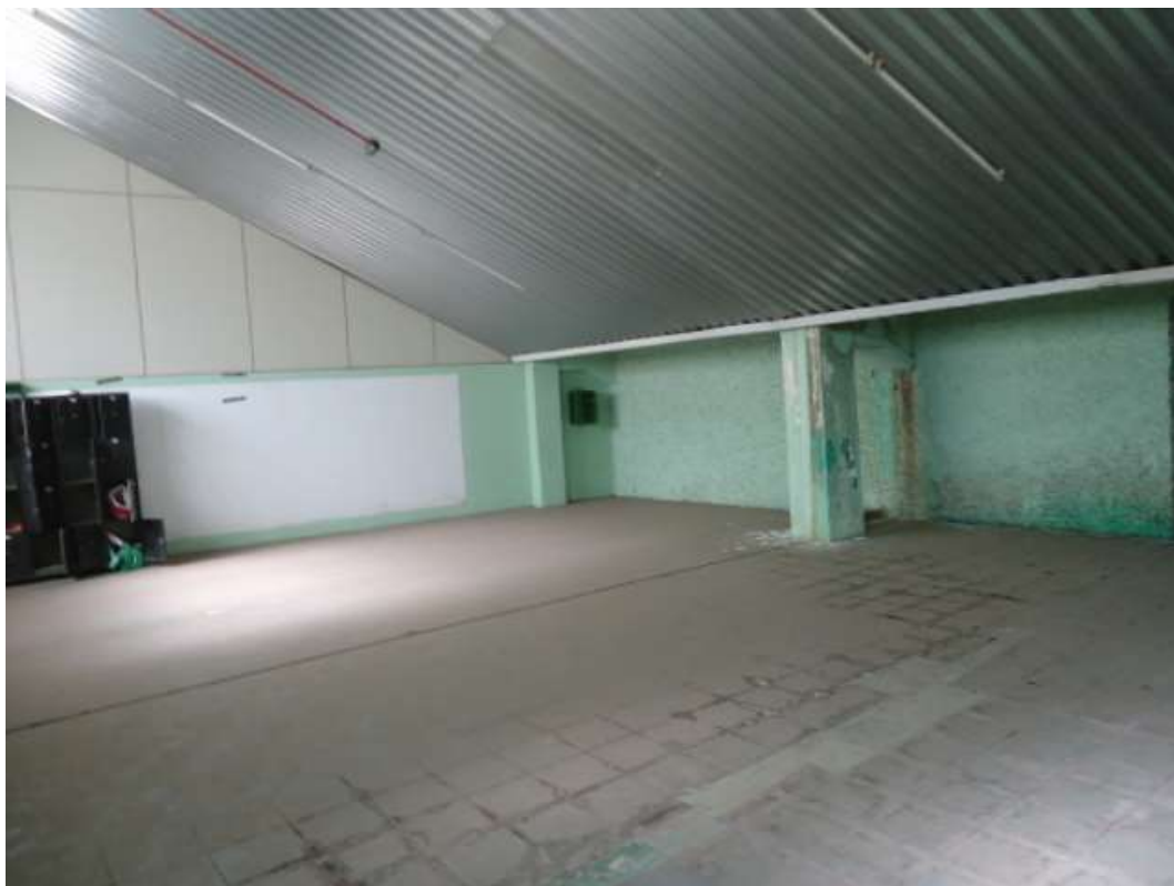
FOTO N.º 139- Aspecto interno da sala ao lado do salão social.
