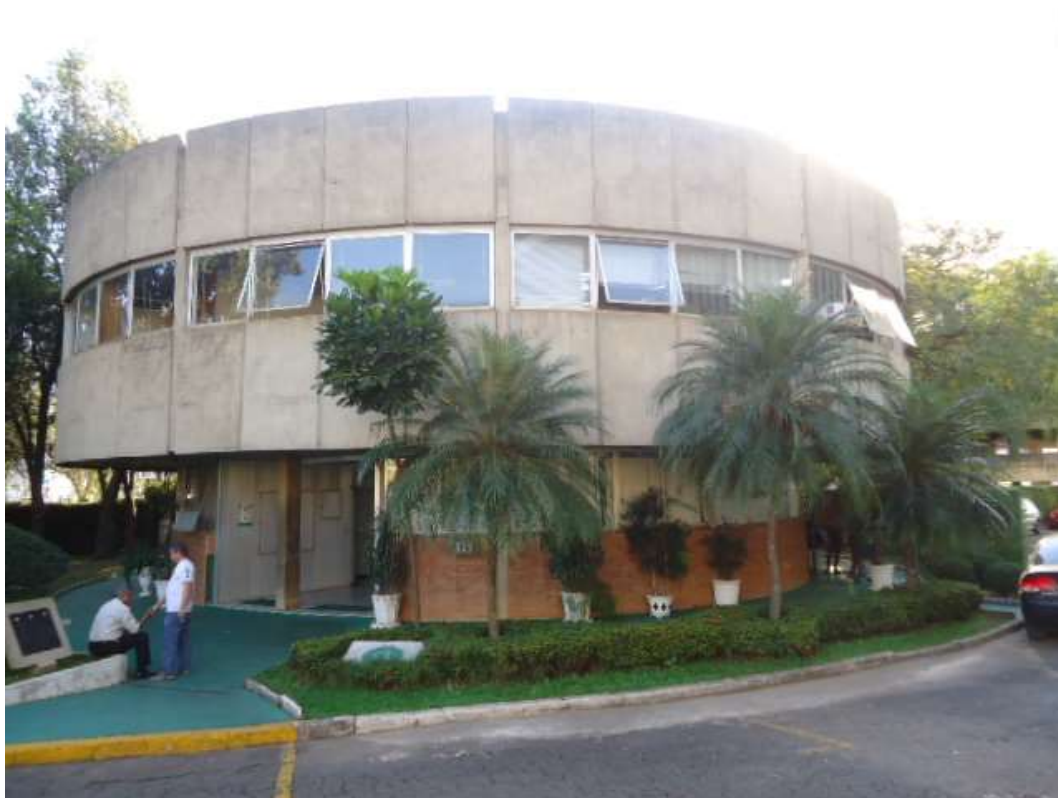
FOTO N.º 317- Vista externa do salão administrativo.
