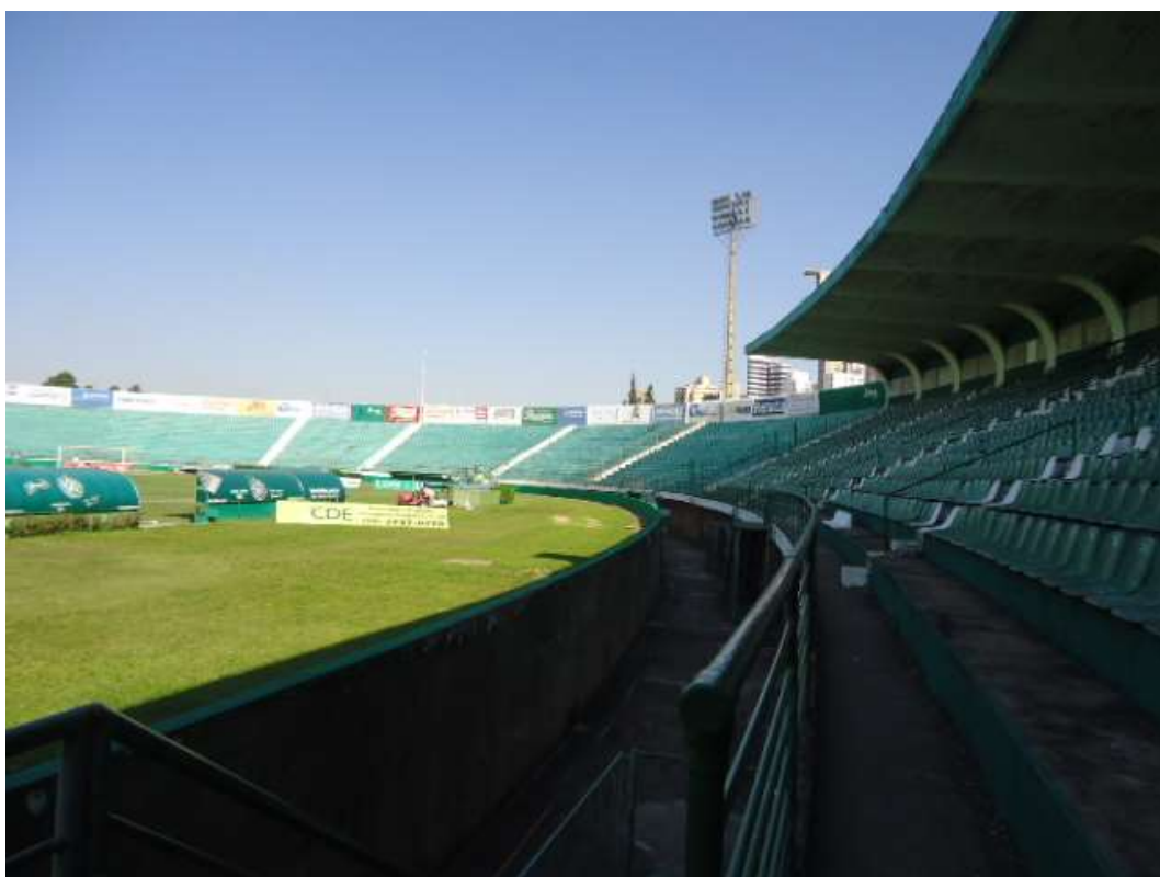
FOTO N.º 117- Aspecto interno do estádio.
