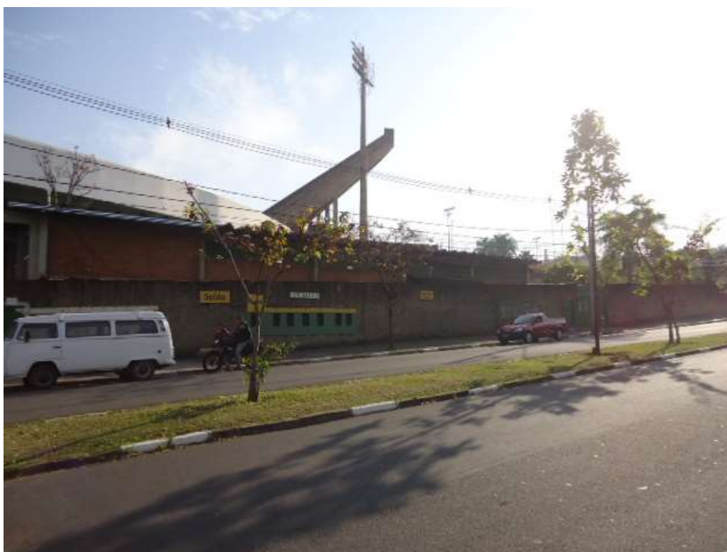
FOTO N.º 03- Aspecto da fachada do estádio, para a Av. Imperatriz Dona Tereza Cristina.
