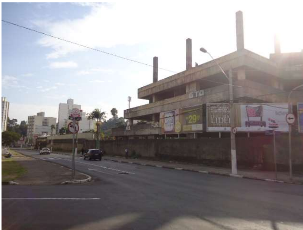
FOTO N.º 15- Aspecto da fachada para a Av. Princesa D'Oeste.
