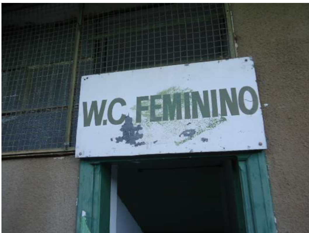
FOTO N.º 109- Detalhe da placa de identificação do banheiro feminino.
