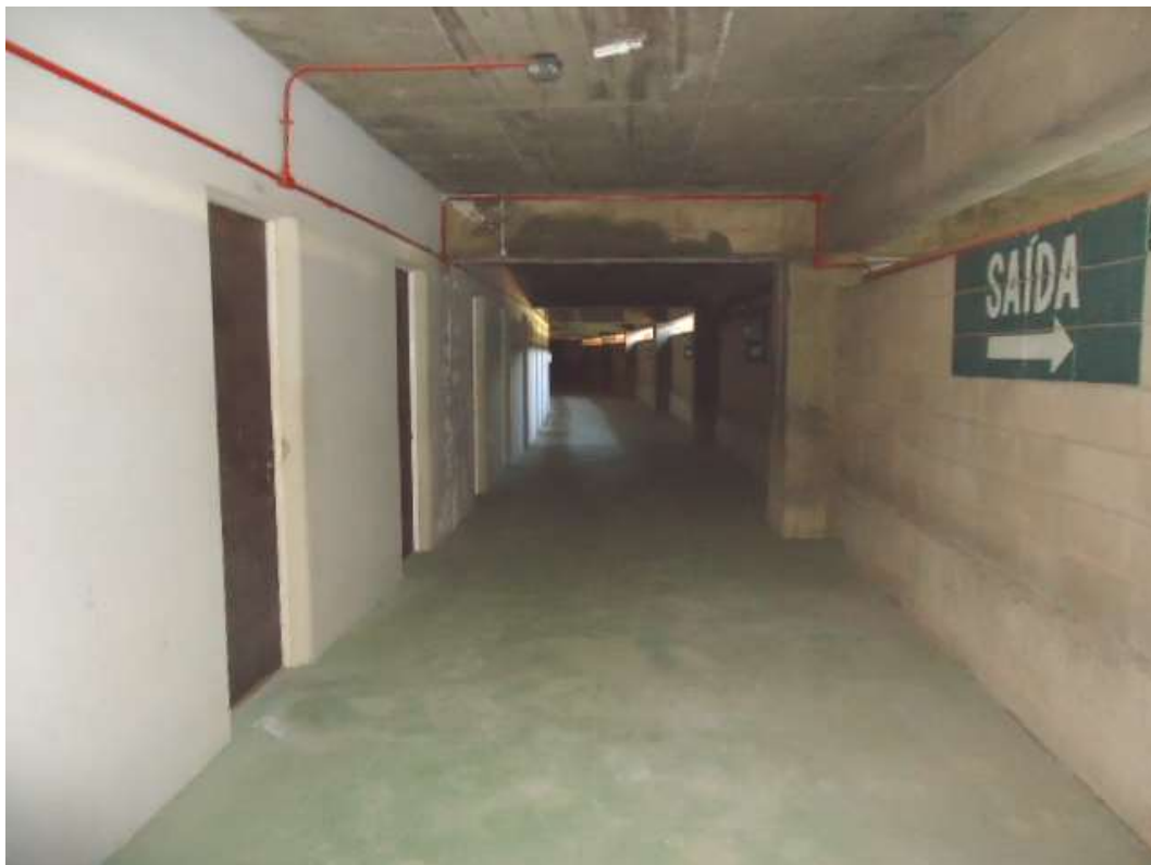
FOTO N.º 265- Tomada do corredor de acesso aos camarotes.
