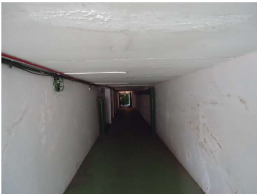
FOTO N.º 164- Vista do túnel de acesso às saunas.
