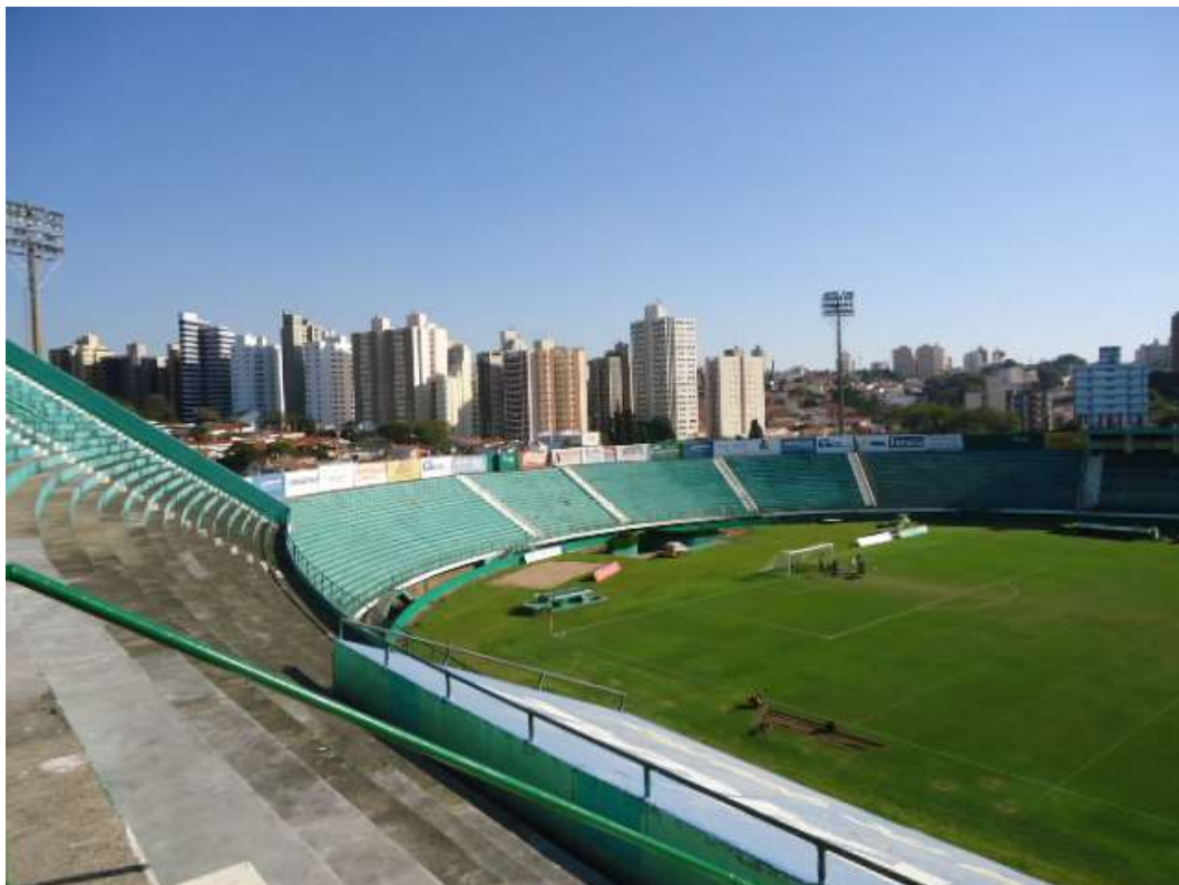
FOTO N.º 276- Aspecto do estádio na arquibancada do setor sul.
