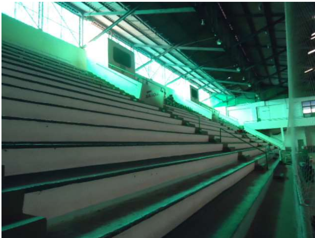
FOTO N.º 222- Aspecto da arquibancada do ginásio de esporte.
