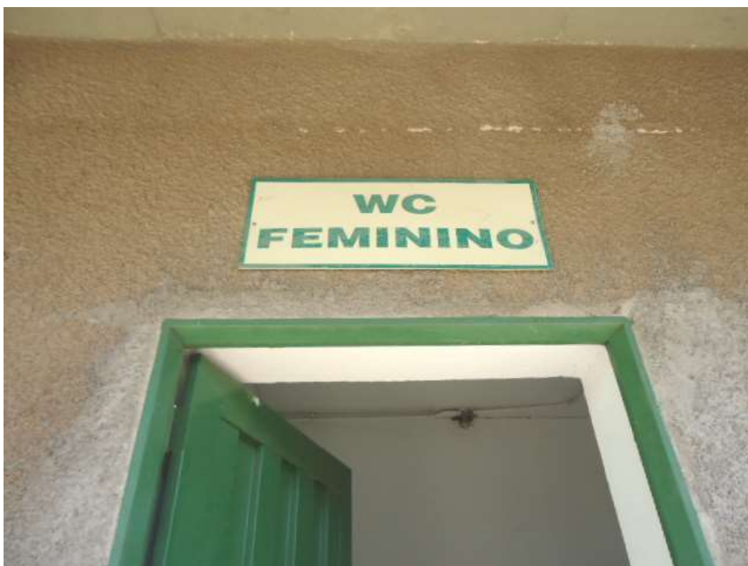
FOTO N.º 80- Detalhe da placa de identificação do banheiro feminino.
