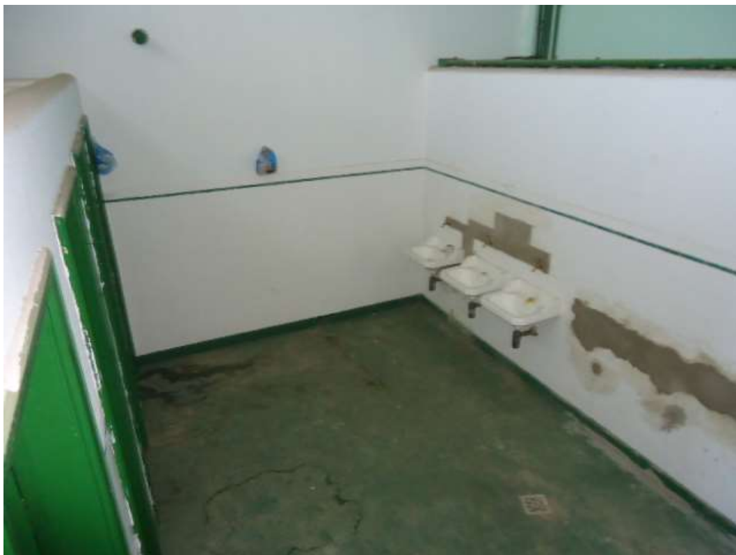
FOTO N.º 110- Tomada interna do banheiro feminino.
