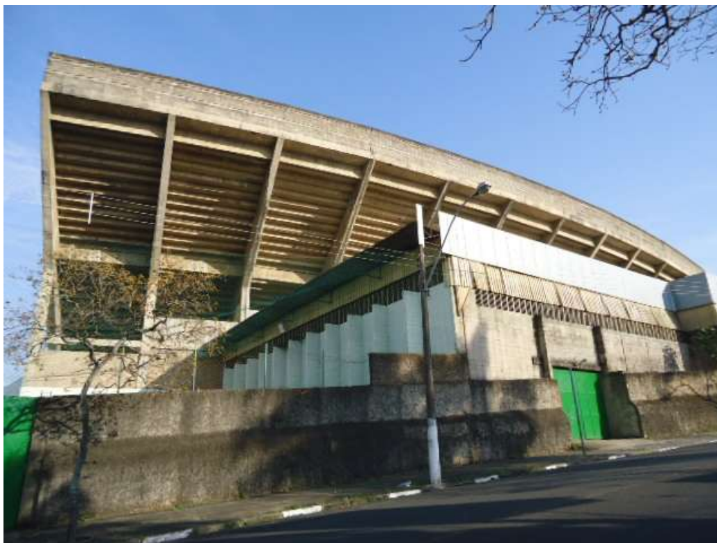
FOTO N.º 28- Aspecto externo do estádio, mostrando a arquibancada denominada de tobogã.
