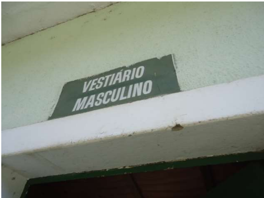
FOTO N.º 241- Detalhe da placa de identificação do vestiário masculino.
