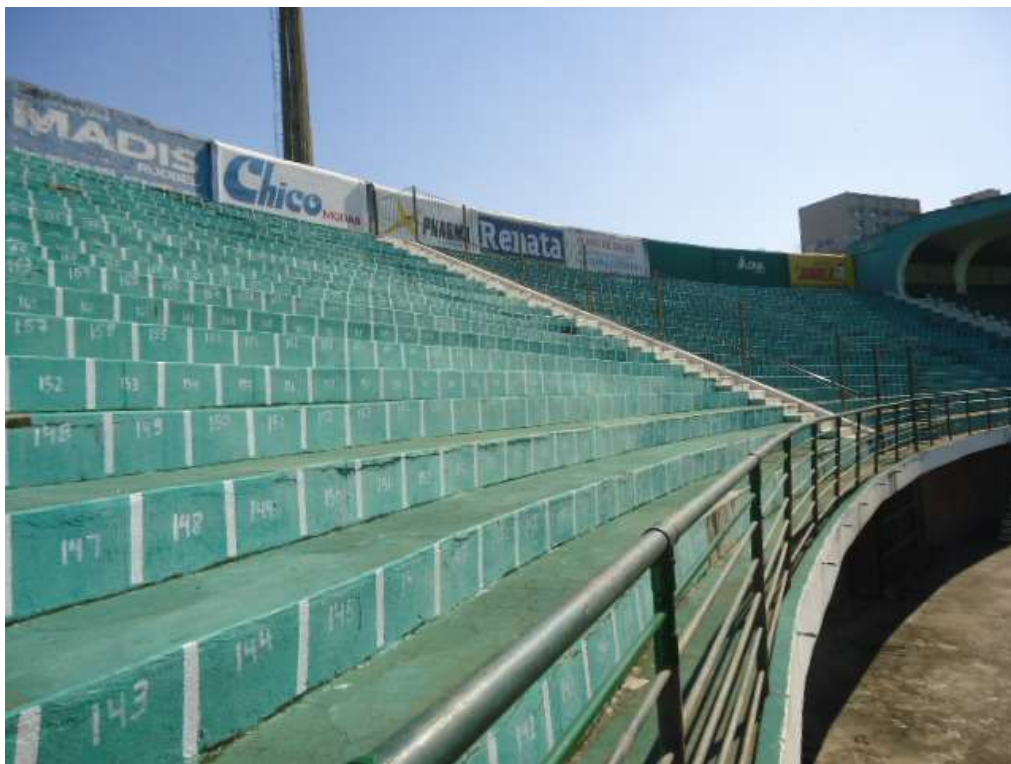
FOTO N.º 87- Vista da cabeceira sul, com 20 degraus de 80 cm de piso por 40 cm de espelho.
