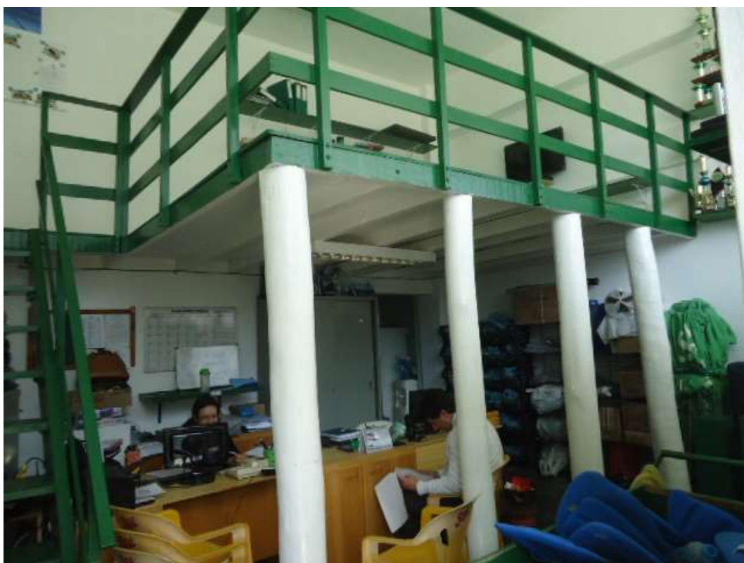
FOTO N.º 162- Vista interna do departamento aquático.
