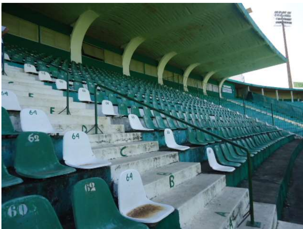
FOTO N.º 119- Vista da arquibancada vitalícia/cativa.
