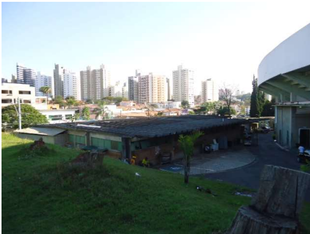
FOTO N.º 290- Tomada do alojamento.
