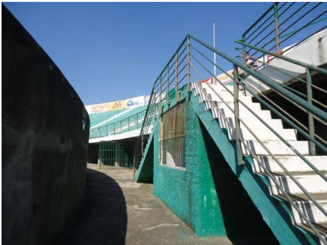
FOTO N.º 85- Aspecto da escada de acesso a cabeceira sul.
