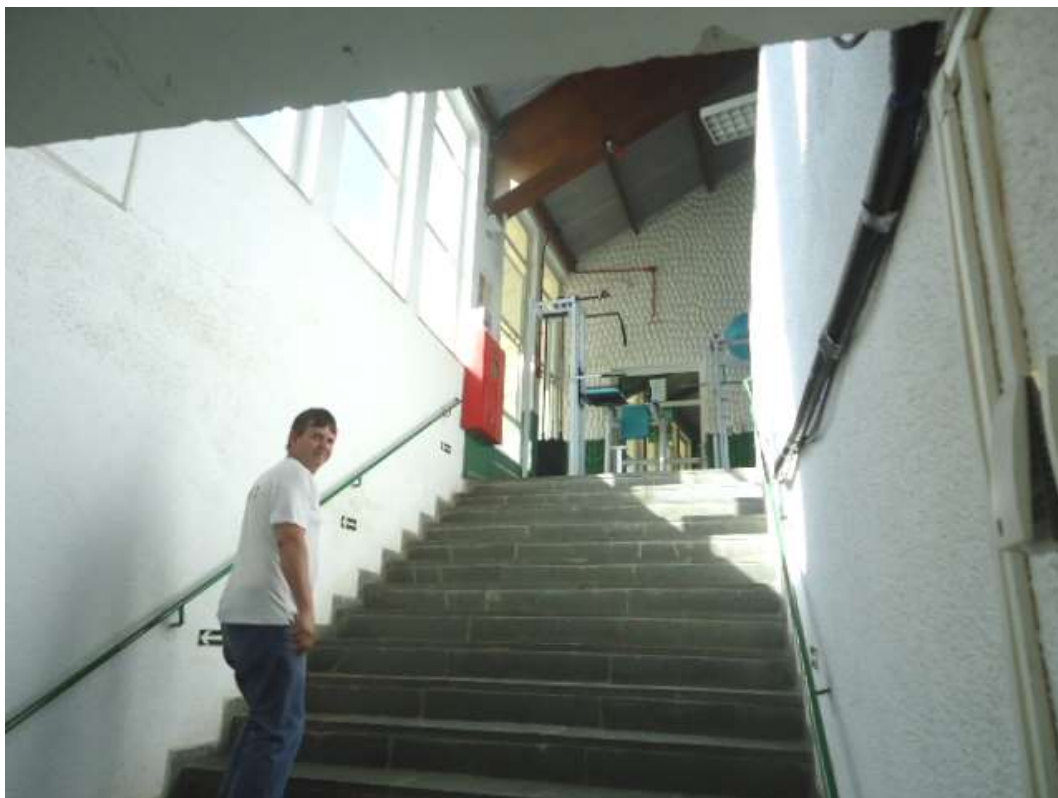
FOTO N.º 196- Vista da escada de acesso ao pavimento superior da academia.
