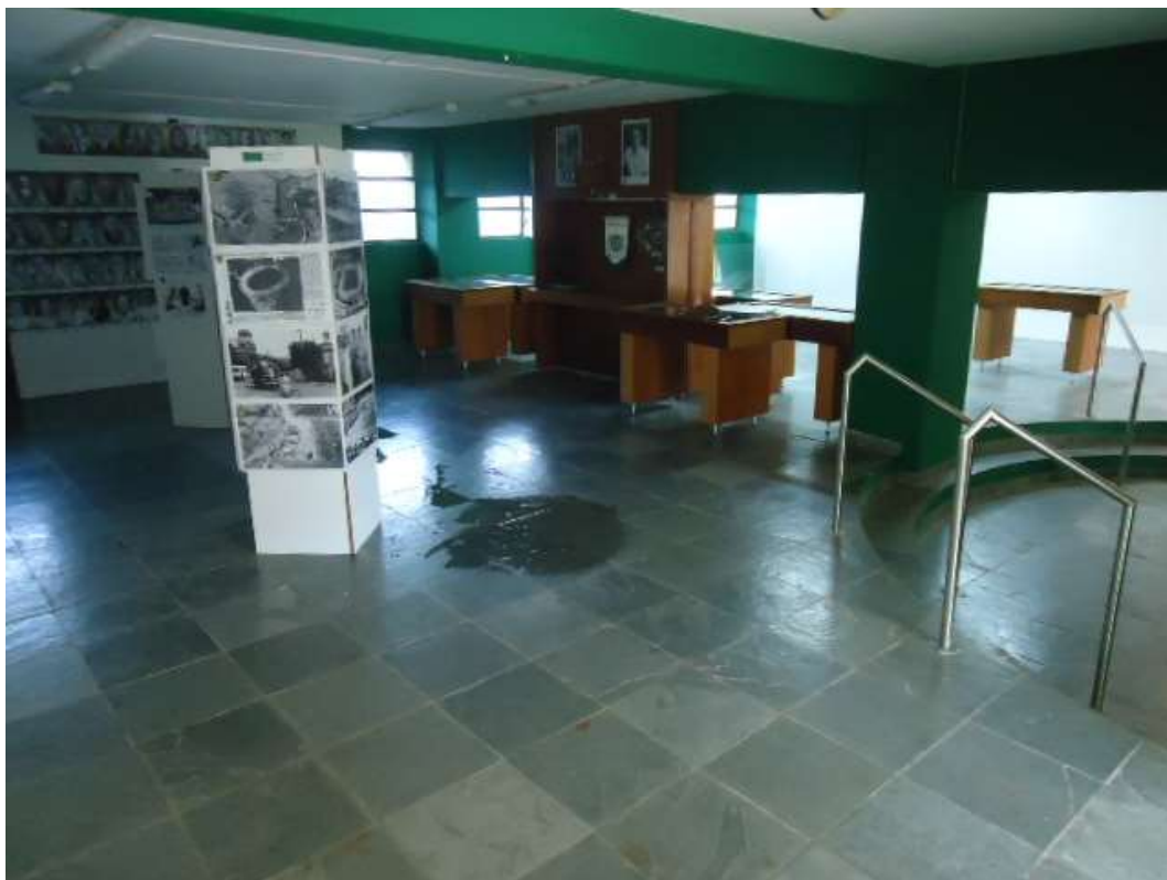
FOTO N.º 143- Tomada interna do memorial no pavimento superior.
