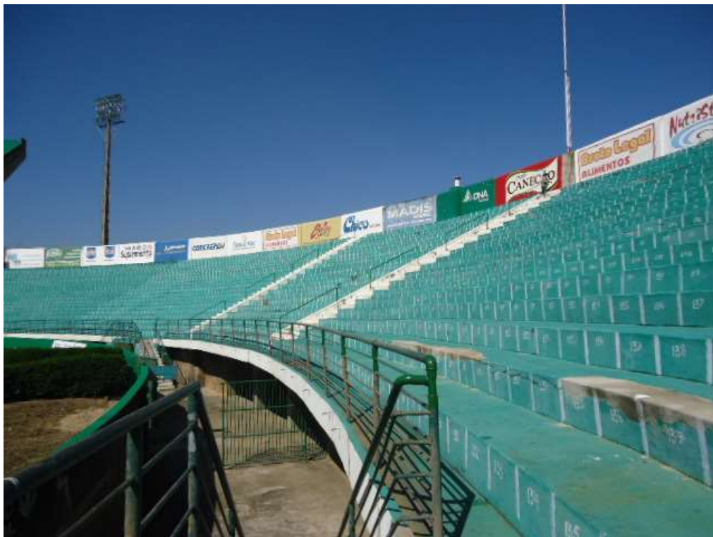
FOTO N.º 86- Tomada da cabeceira sul, com 20 degraus de 80 cm de piso por 40 cm de espelho.
