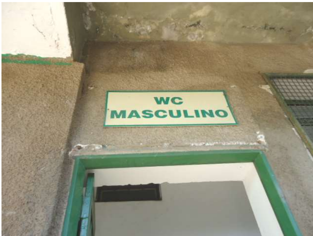
FOTO N.º 82- Detalhe da placa de identificação do banheiro masculino.
