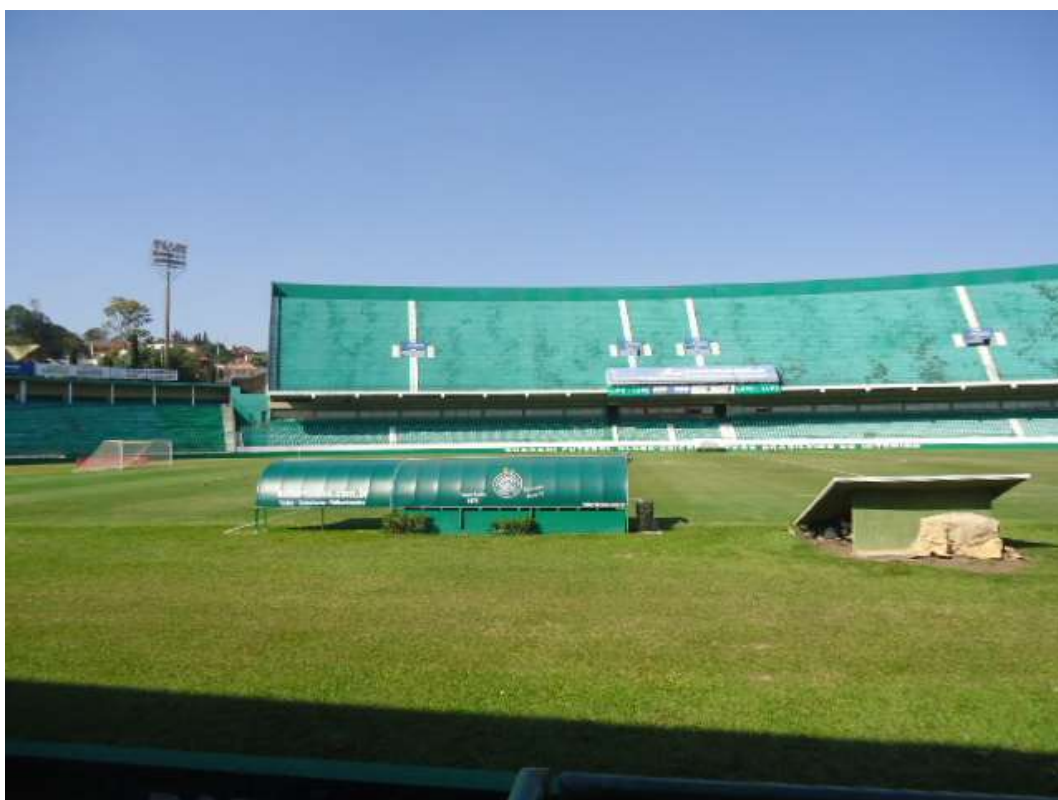
FOTO N.º 115- Aspecto interno do estádio.
