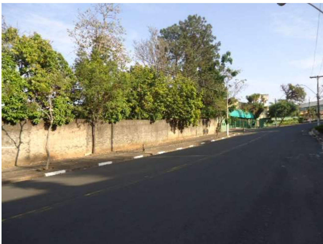
FOTO N.º 35- Tomada da fachada para a Av. Guarani.
