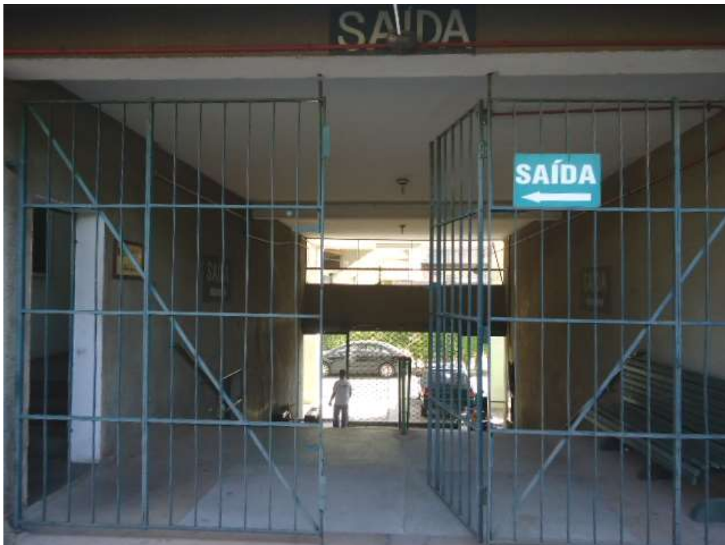
FOTO N.º 88- Tomada da saída de emergência.
