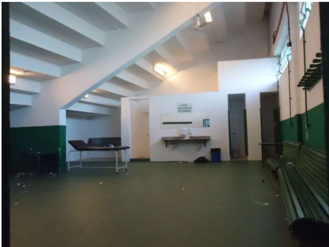
FOTO N.º 293- Aspecto interno do vestiário do time visitante.
