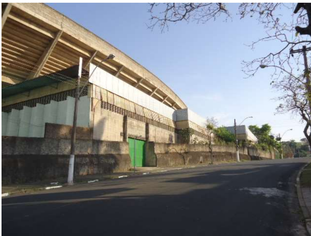
FOTO N.º 29- Vista externo do estádio, mostrando a arquibancada denominada de tobogã.
