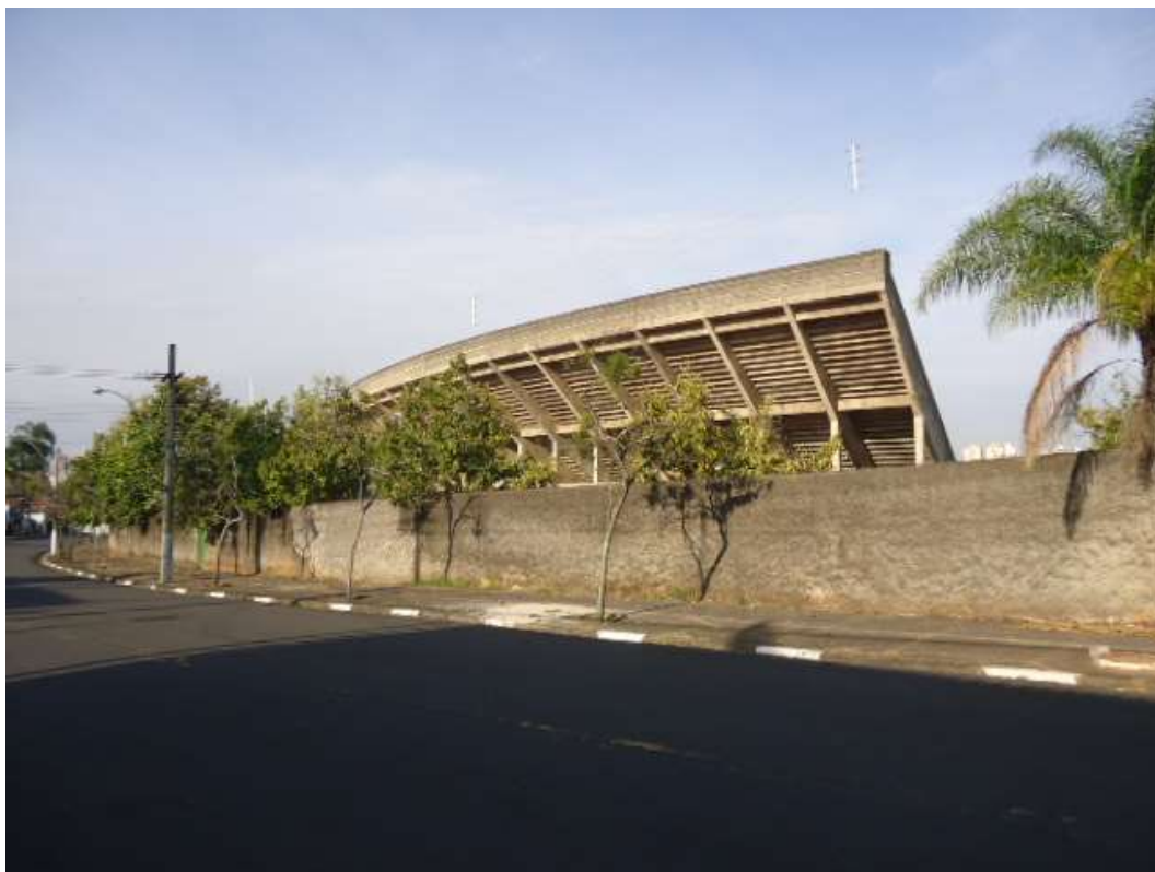
FOTO N.º 34- Vista da fachada para a Av. Guarani.
