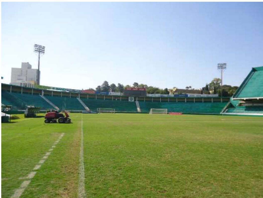
FOTO N.º 73- Tomada da arquibancada para visitante, na cabeceira norte.
