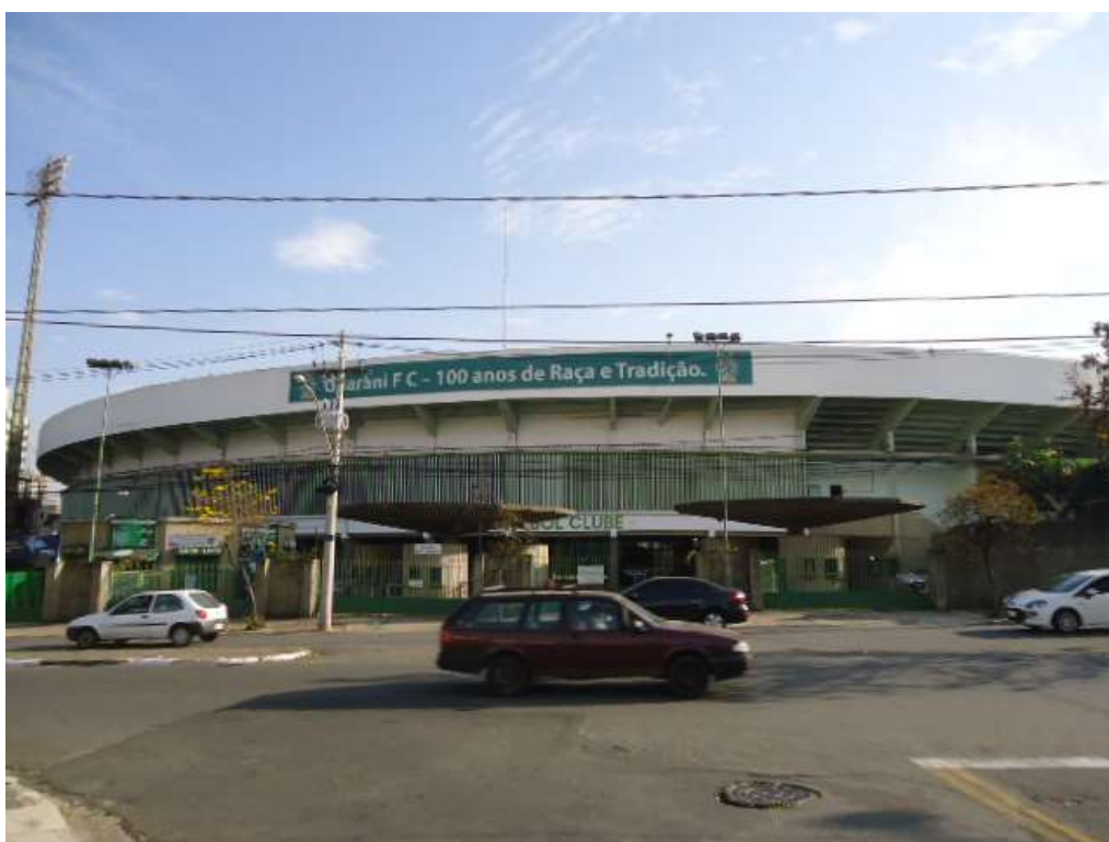
FOTO N.º 05- Vista da fachada do estádio, para a Av. Imperatriz Dona Tereza Cristina.
