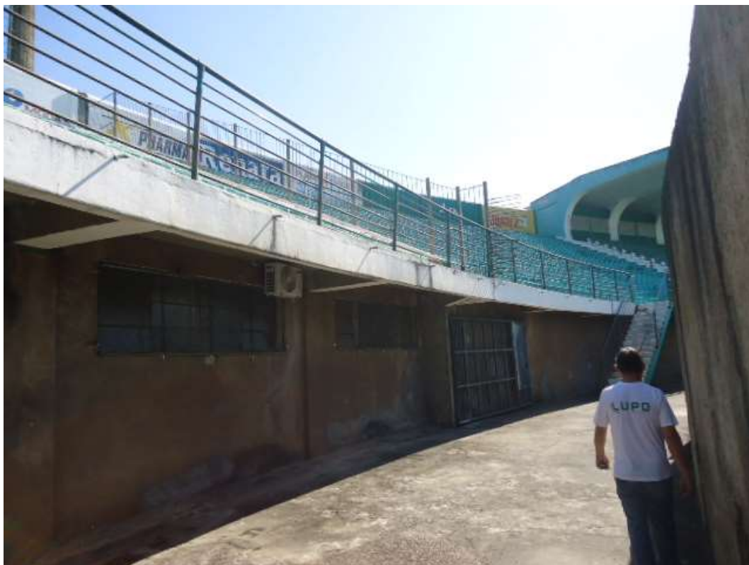
FOTO N.º 84- Vista do fosso, na cabeceira sul, separando a arquibancada do gramado.
