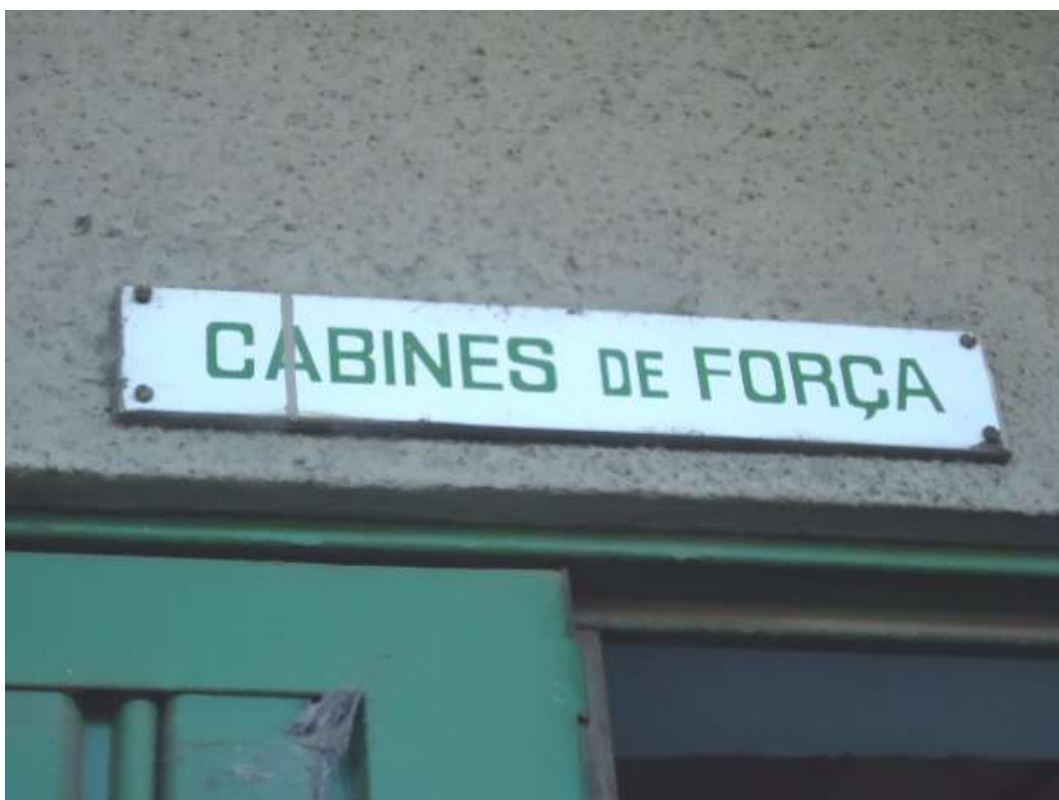
FOTO N.º 51- Detalhe da placa de identificação da cabine de força.
