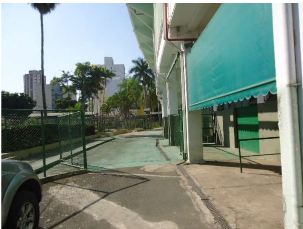
FOTO N.º 154- Tomada de rua de circulação interna pavimentada.
