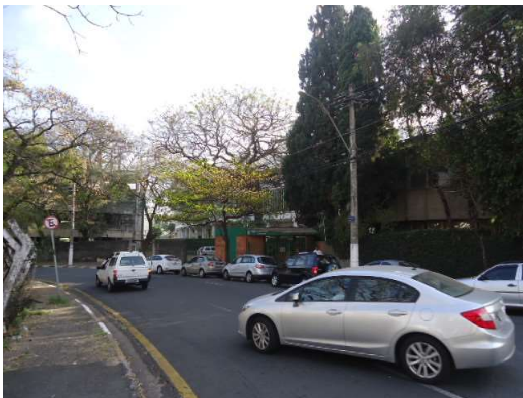
FOTO N.º 09- Vista da fachada voltada para a Rua Conde D'Eu.
