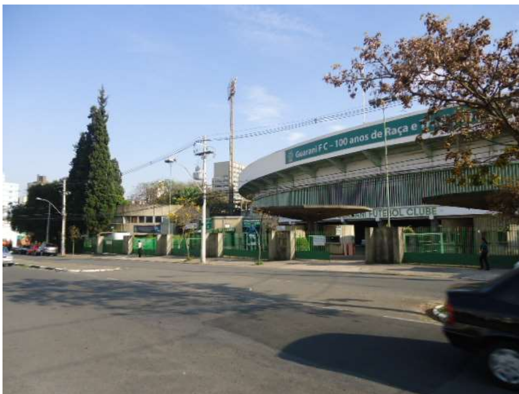
FOTO N.º 07- Aspecto da fachada do estádio, para a Av. Imperatriz Dona Tereza Cristina.
