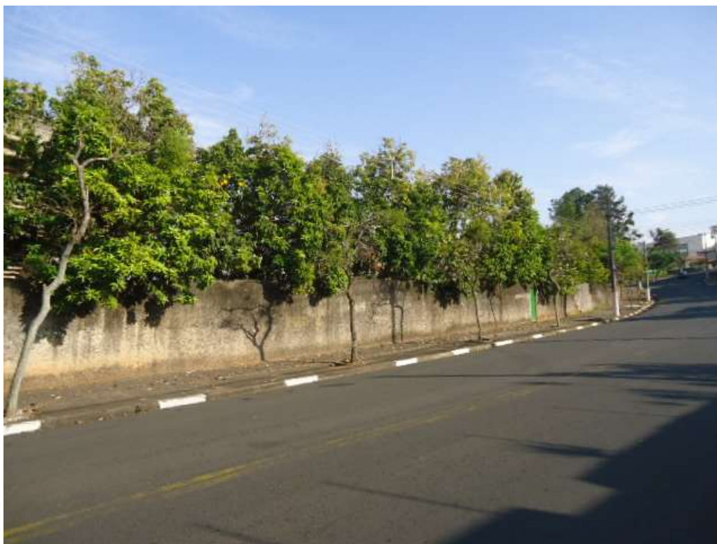
FOTO N.º 33- Tomada da fachada para a Av. Guarani.
